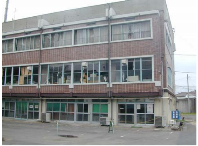
写真2 鹿島台町役場庁舎（危険なため立ち入り禁止）
