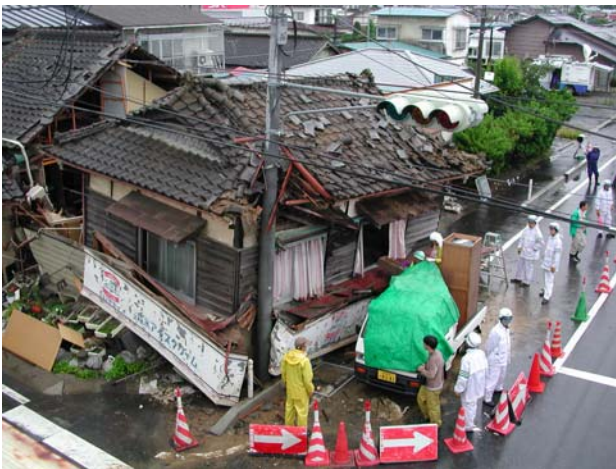
写真5 矢本町 国道45号線沿い住家の倒壊 (2階建て民家の1階部分が座屈)
