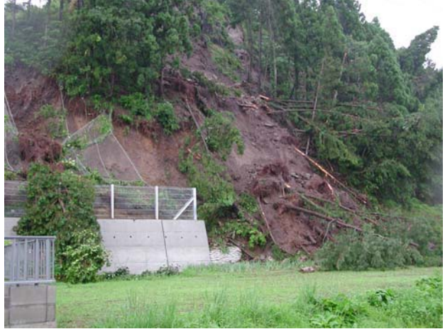
写真 14 鳴瀬町（小野大欠山）の崖崩れ
