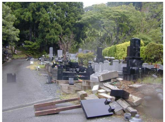
写真6 矢本町の墓石倒壊（南西に倒れているもの多い）
