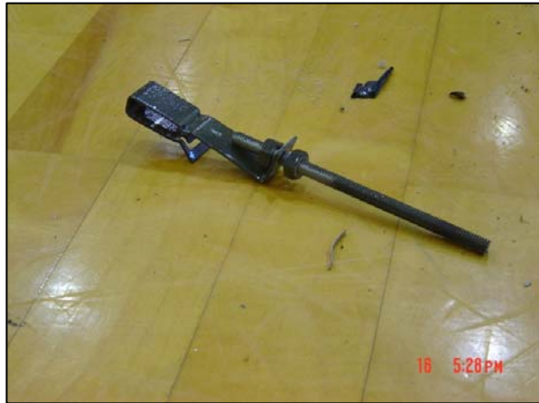
川崎町 B&G 海洋センター天井部材
