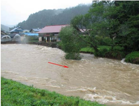
①増水した杉倉川による川岸の侵食（田子町） 〔矢印は流れの方向〕 写真提供：青森県
