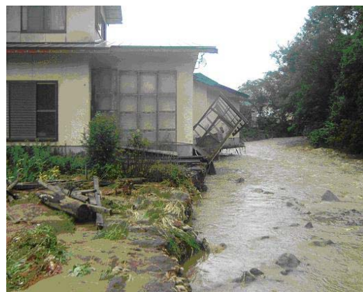
⑧河川増水による住家の損壊(八幡平市)
