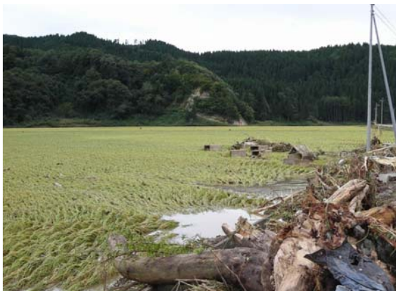
⑤流木及びコンクリート製 U 型側溝が流入した水田 （北秋田市） 写真提供：秋田県
