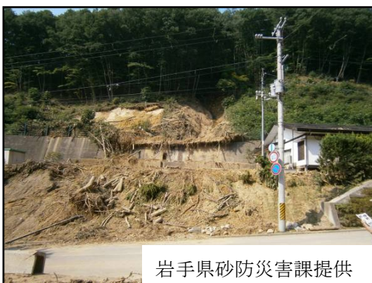
がけ崩れ 8/14 盛岡市繫字湯ノ館
