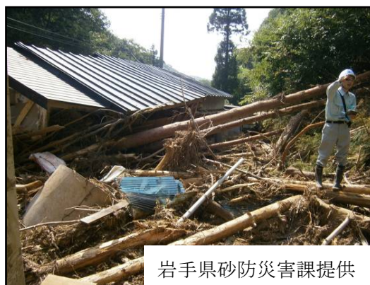
がけ崩れ 8/14 盛岡市繫字湯ノ館
