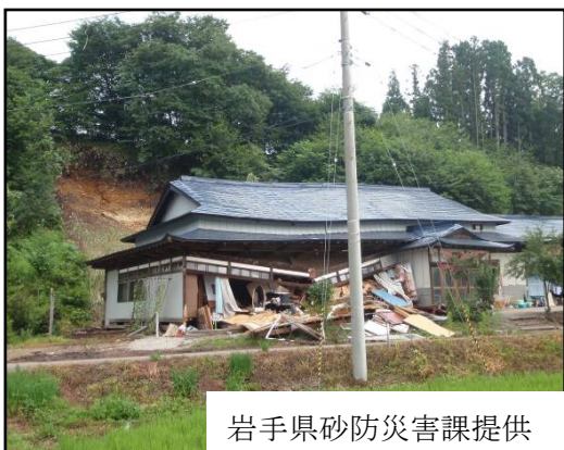
がけ崩れ 8/11 雫石町西安庭
