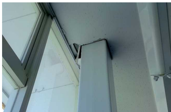
写真3-25 天井の破損
