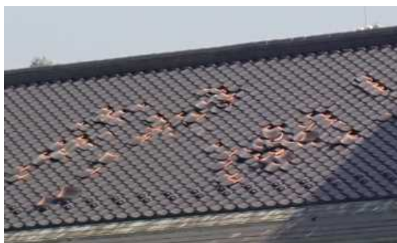
写真３－３４ 瓦のずれ
