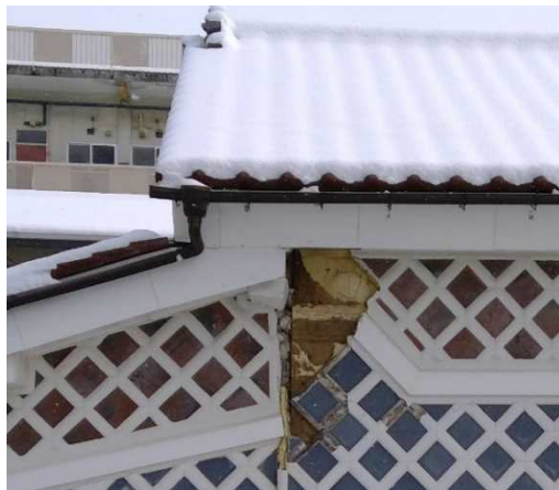
写真 3-20 壁の損壊
