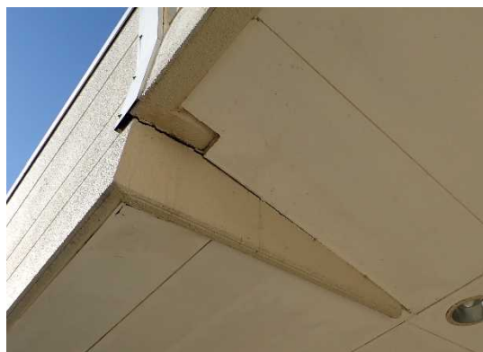
写真3-29 外壁の亀裂
