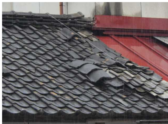
写真3-22 瓦のずれ
