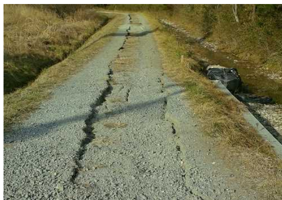
写真3-7 農道の亀裂
