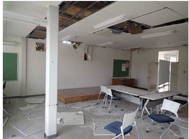
写真4：天井の破損
