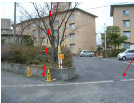
16_市営住宅（撮影：西 東） 酒田市東大町
