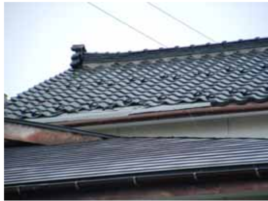
10_飲食店の屋根瓦（撮影：南 北）
