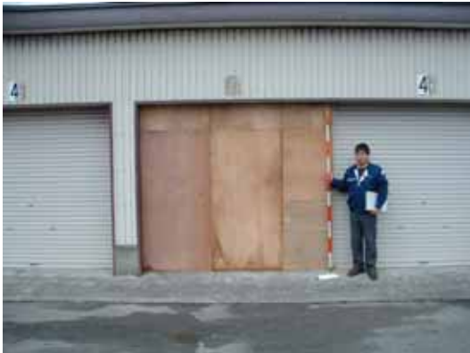
01_車庫（撮影：北 南） 酒田市山居町
