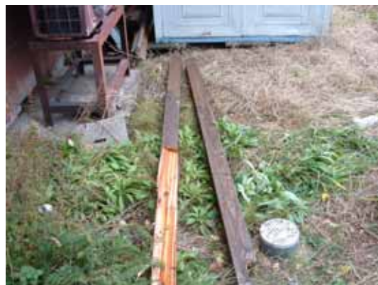
12_飲食店の看板支柱（建物東側）
