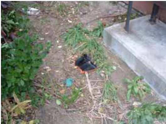
13_飲食店の屋根瓦（建物東側）
