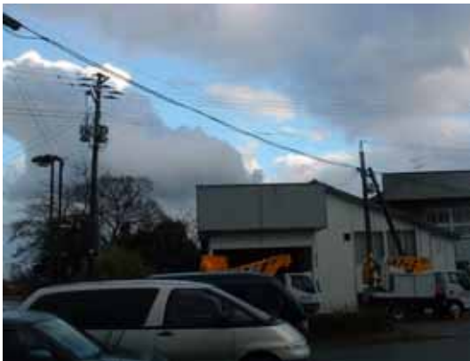
19_電話線張替工事（撮影：北西 南東）
