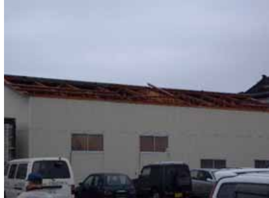
22_会社倉庫屋根拡大 ( 撮影 : 北西 南東 )
