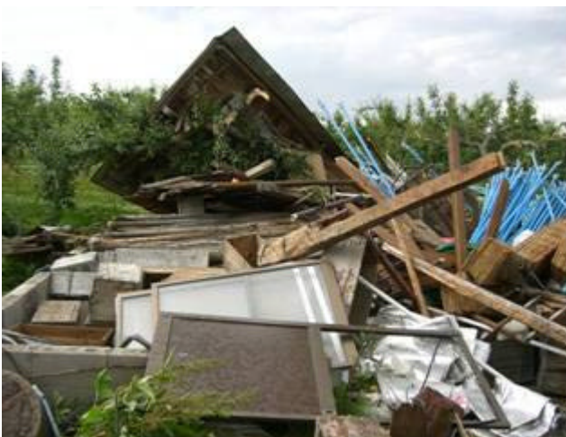
11_住家 B 裏側 (西側) の小屋が西側に倒壊 (撮影: 東 西)
