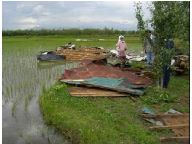
22_住家 C 裏付近の飛散物 (トタン屋根) (撮影：西 東)
