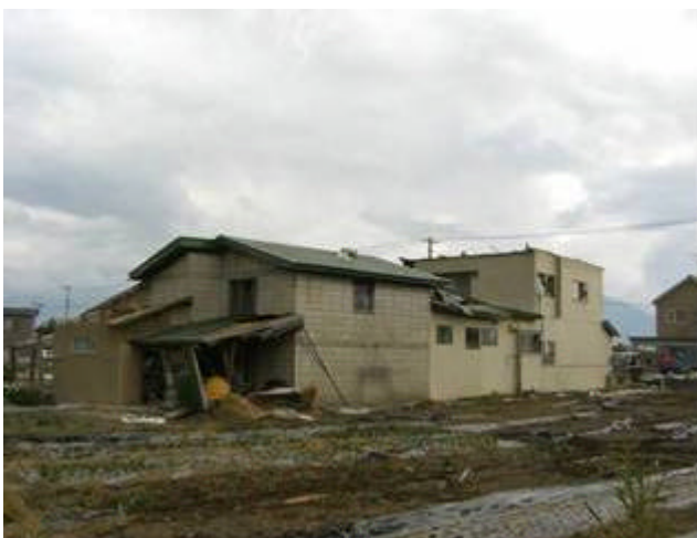
05_住家 A の裏側方向 （撮影：北東 南西）
