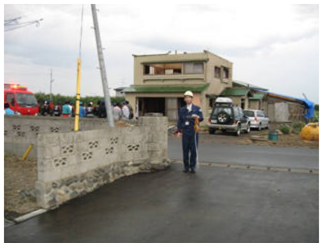
18_ブロック塀の上部が北側に落下 (撮影：西 東)
