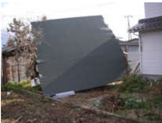
写真 09 基礎の一部が破損し倒壊した木造車庫 (民家 3) (遊佐町役場撮影)
