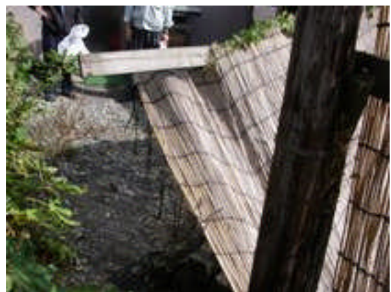
写真 18 物置小屋の囲いが破損 （遊佐町役場撮影）
