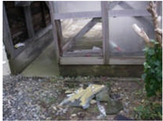
写真 17 車庫北側のガラスが 1 枚外側に破損（民家 5 所有） （遊佐町役場撮影）
