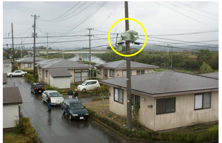
③ 電柱の飛散物 (西側から撮影)
