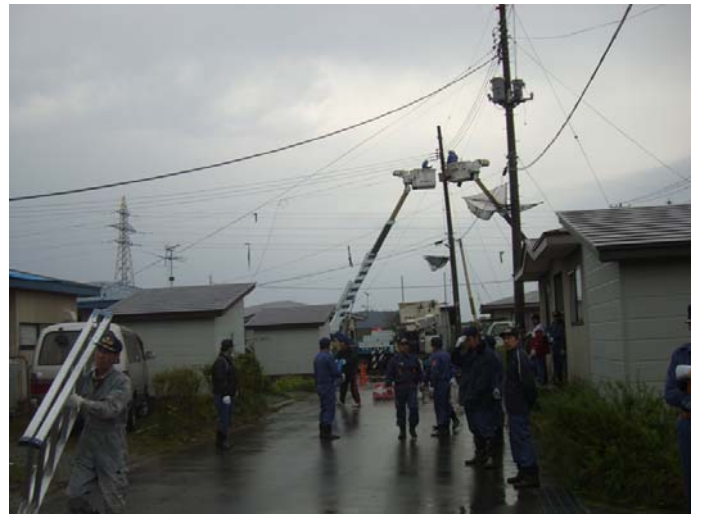
⑤ 電線の飛散物撤去作業中 (西側から撮影)
