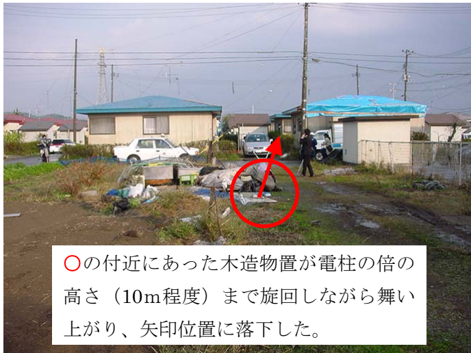
④ 木造小屋跡 (西側から撮影)
