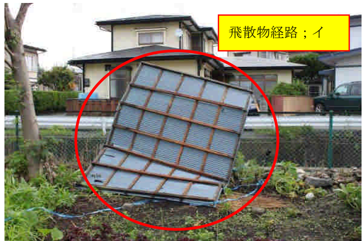
写真 E 写真 J の飛散物(2m×2.5m)
