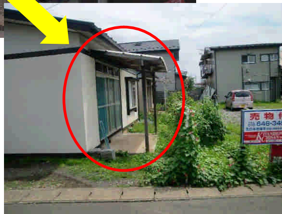
写真 L 聞取り調査⑧の住宅正面の住宅（居住者なし） 写真 K のひさしと形状同等。この住宅のひさしは被害無し
