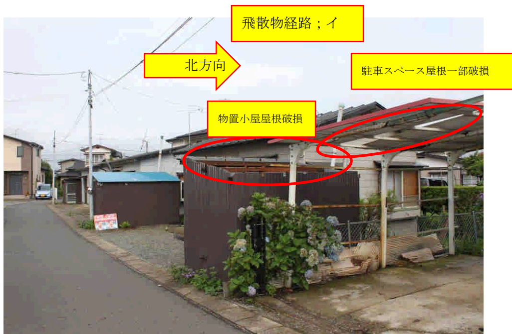
写真 J 被害が多かった地域の通りを東から西方向に撮影（写真提供；盛岡西消防署） 物置小屋の屋根が飛ばされ、写真 E の位置でフェンスに引っかかる。この住宅では、 ひさしが、写真 F 又は写真 G へ飛散したと思われる。また、聞き取り調査⑤の住宅の駐 車スペース屋根一部破損。
