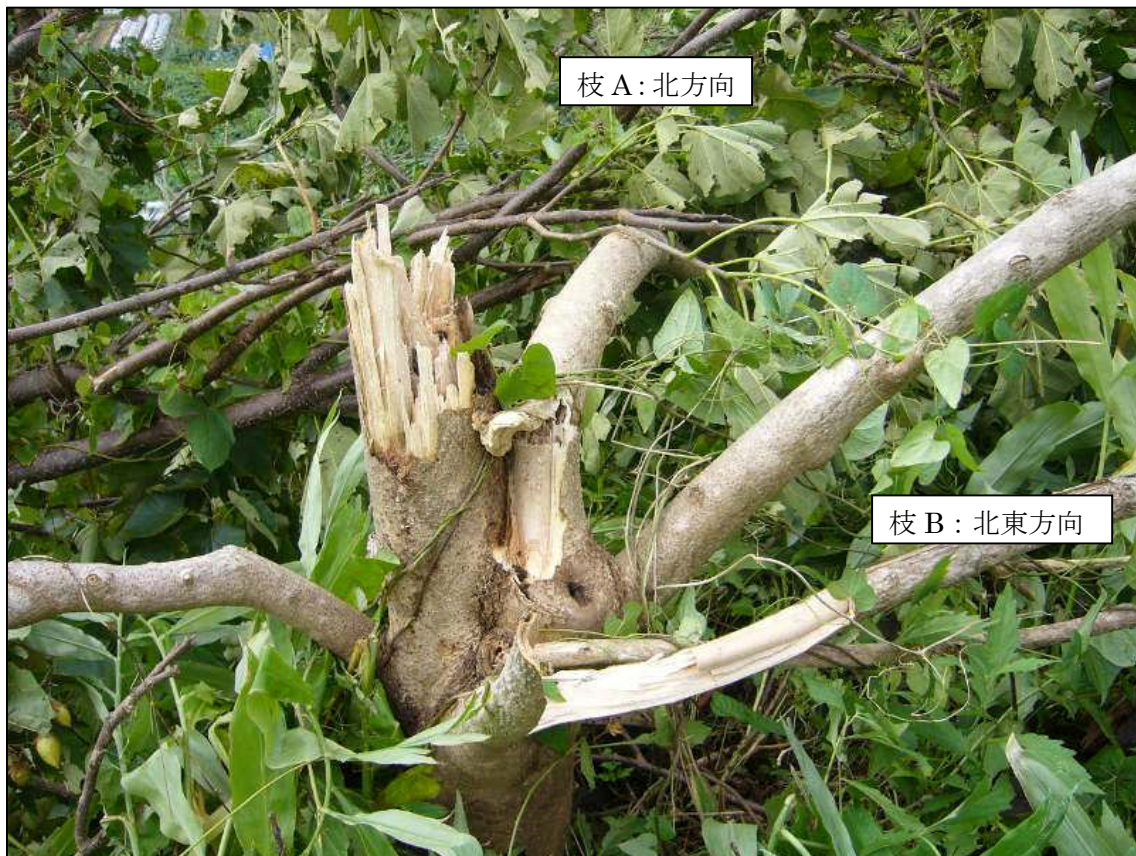
【写真 15】樹木の幹 (直径 15cm) が折れ、周りの枝 (直径 7cm 前後) がねじ切れている。折れた先の幹は北へ飛ばされ、枝 A は北、枝 B は北東方向に倒れている。(⑨地点)
