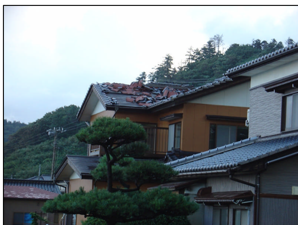
【写真 03】住家南～西側の瓦破損（②地点） （鶴岡市温海庁舎総務課提供）
