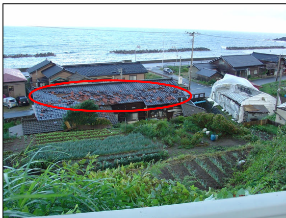
【写真 10】 南東側の瓦が多数剥がれる (⑥地点) (北西側少数) (鶴岡市温海庁舎総務課提供)
