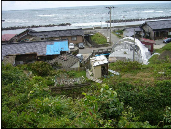
【写真 13】ビニールハウスのビニールが南東側から北西側に向かって剥がれている (⑧地点)
