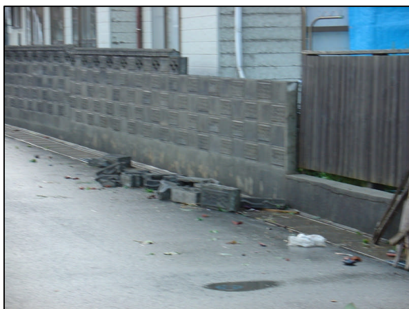
【写真 11】 ブロック塀上部が北西側に落下 (⑥地点) (鶴岡市温海庁舎総務課提供)
