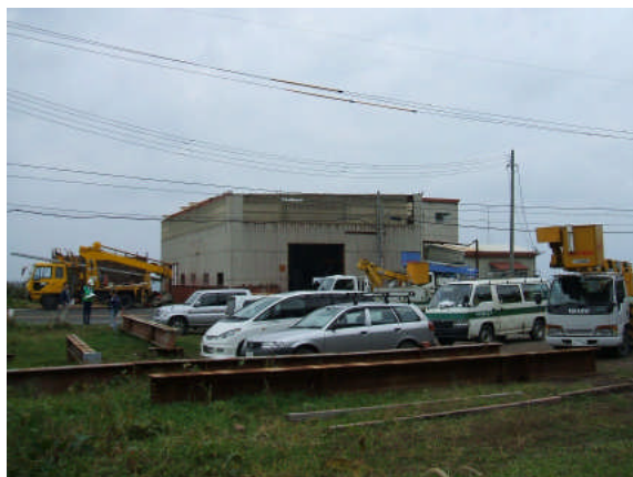
①被害のあった鉄工所東側 (撮影：東南東→西北西)
