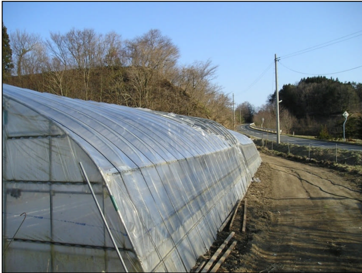
① 損傷ビニールハウス(西側) ビニール破損・骨組みが盛り上がる
