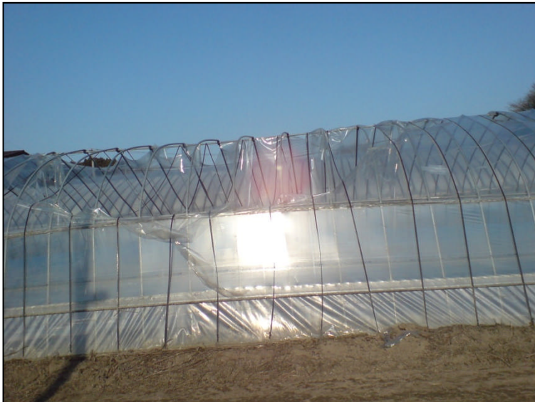
③ 損傷ビニールハウス(西側) ビニール破損・骨組み盛り上がる
