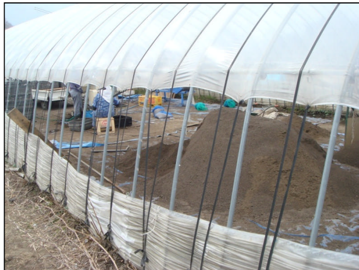
7. 被害ビニールハウスBの内部 内部では苗床づくり中、土が盛られている
