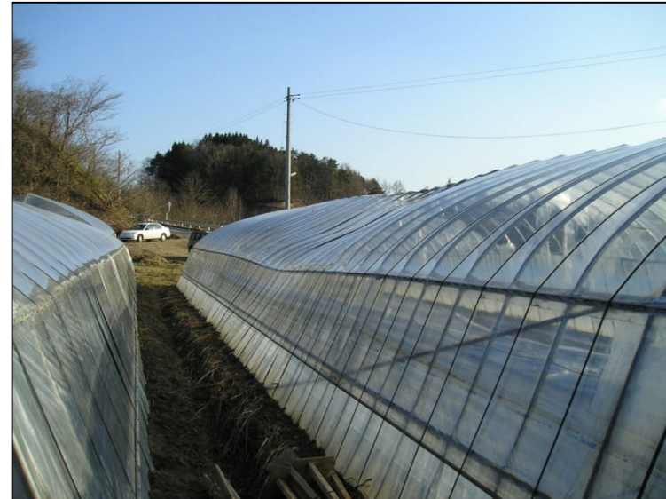
② 損傷ビニールハウス(東側) 骨組みがへこむ
