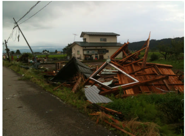
② 15時15分頃(推定)、車庫兼物置が倒壊、一部北側へ20m飛ばされた。(北側から撮影)
