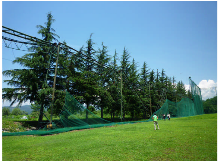
⑧ 15時15分頃、ゴルフ場の防球ネットの鉄柱（高さ25m） 14本が中ほどから北側に折れた。（南東側から撮影）
