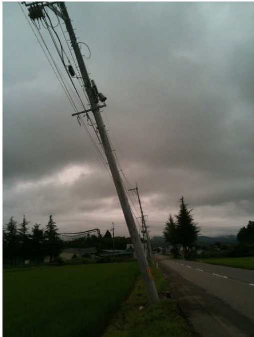
⑦ 電柱が北側に傾いた。 (西側から撮影)
