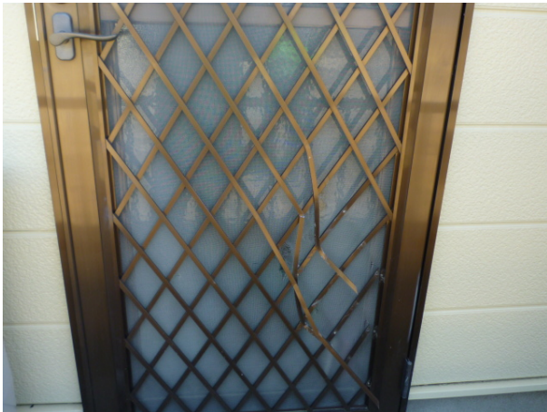
③ 飛散物により北側入り口戸と柵の一部破損（北側から撮影）
