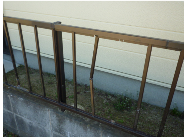
③ 飛散物により北側入り口戸と柵の一部破損（北側から撮影）
