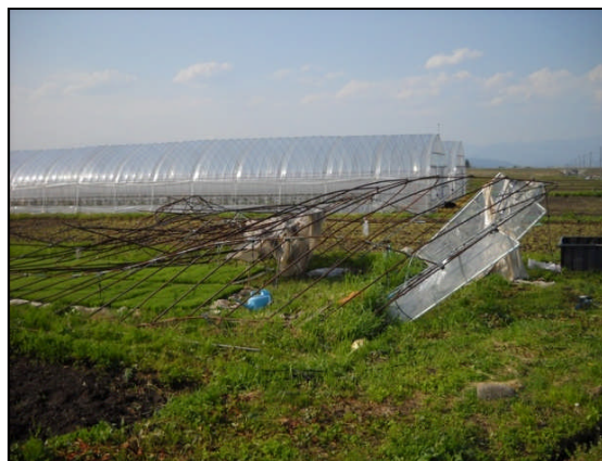
⑬ ビニールハウス損壊（南から撮影）
