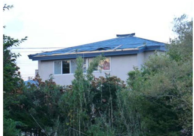
④屋根のトタンが北側に剥離した住家 （南東から撮影）
