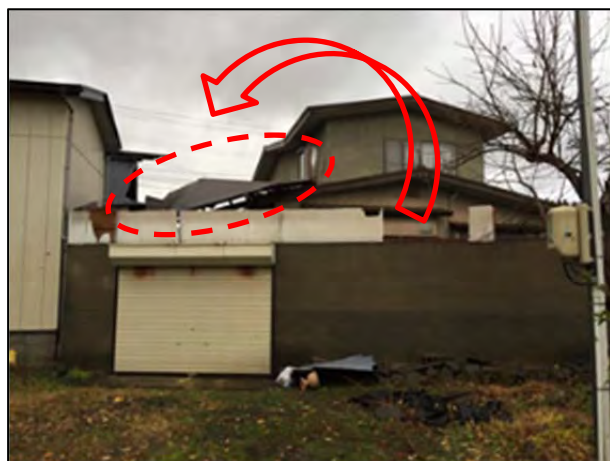
③ 屋根が骨組みごと飛ばされた物置小屋 (南から撮影)
