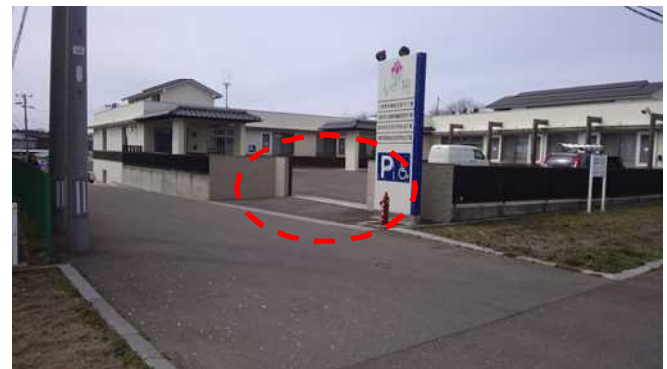
金属製の門扉が南東方向へ飛散(南東側から撮影)
