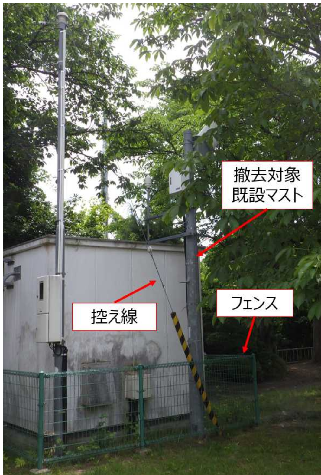
観測局舎のフェンス及び受電柱の控え線（現況）
