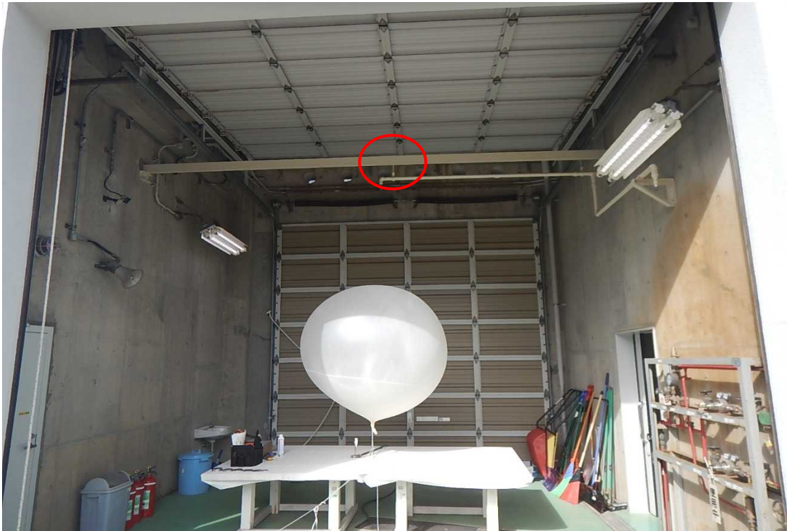
図 2 気球棟拡散式ガス検知部（充填室）
