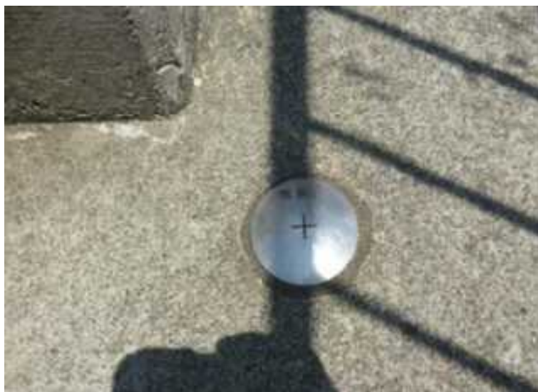
測量標（金属鉾）設置例
