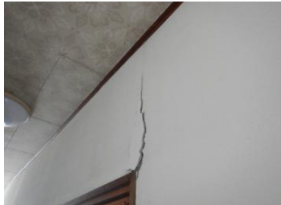
写真 2 民家の壁の亀裂（八戸市湊町）
