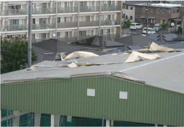
① 屋根がめくれたテニスコート (南西方向から撮影、 日本大学三島高校提供)
