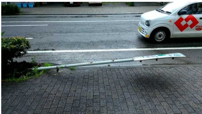
⑤ 倒れた標識 (東方向から撮影)
