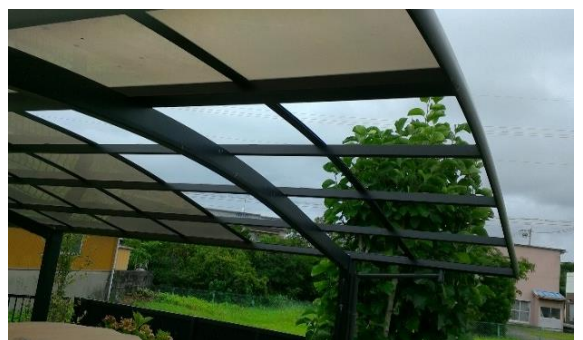
⑥ パネルが飛散したカーポート (南方向から撮影)
