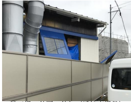
②工場の外扉の外れ（浜松市提供）
