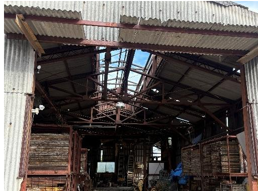
④ 鉄骨造倉庫の屋根ふき材の飛散（西から東へ撮影）
