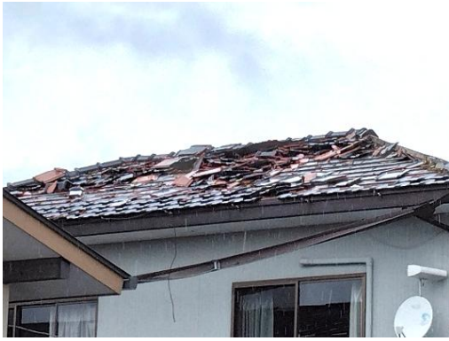
① 木造家屋の屋根瓦の飛散（北から南へ撮影）
