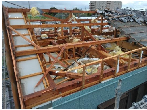
② 木造家屋の小屋組の損壊（東から西へ撮影）
