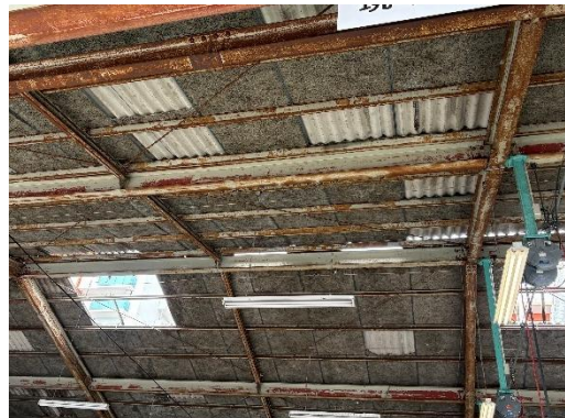
⑥ 鉄骨造倉庫の軽微な被害（明り取り用の屋根材の一部はがれ）（南から北へ撮影）
