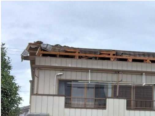
③ 木造家屋の屋根軒先と野地板の飛散（南西から北東へ撮影）
