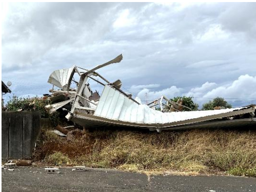
⑤ プレハブ車庫の倒壊（東から西へ撮影）
