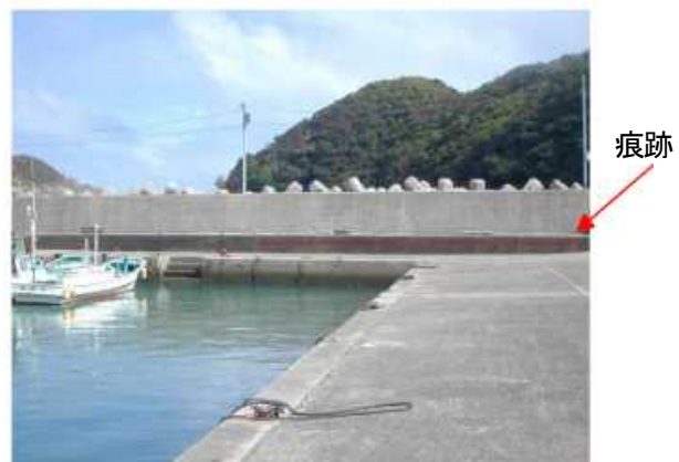
写真2 和歌山県串本町大島 須江漁港 津波は防波堤の入り口からはいり赤線の所まで押し寄せた（岸壁から40cm、資料3による）
