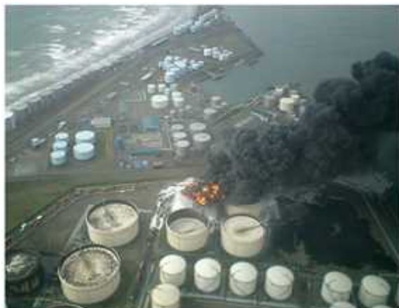
写真1 平成 15 年(2003 年)十勝沖地震では震央から約 250km 離れた苫小牧市内で長周期地震動により揺動した石油タンクの浮き屋根が沈没し、地震から 2 日後に火災が発生(総務省消防研究センター提供)
