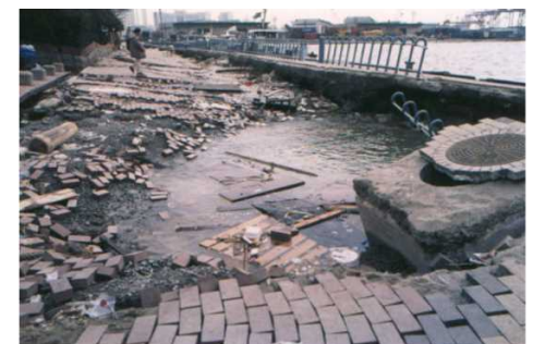
写真 水没した道路（神戸市中央区）
