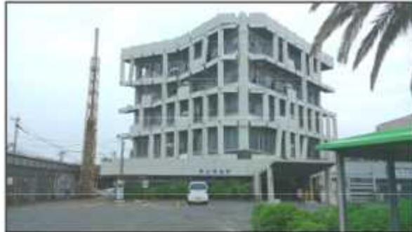
写真5 宇土市役所の損壊(宇土市浦田町)(資料4)
