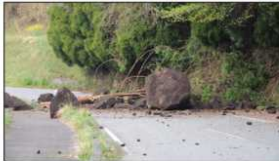
写真7 道路への落石(産山村山鹿:産山村提供)(資料4)
