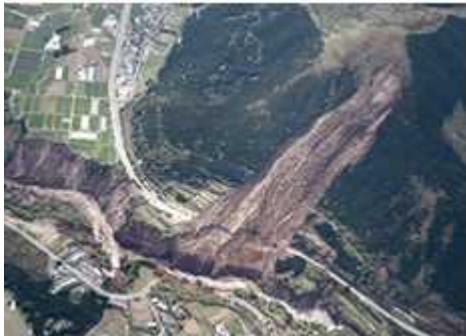
写真3 地震による大規模な土砂崩れで阿蘇大橋が崩落し死者も発生した(資料1)
