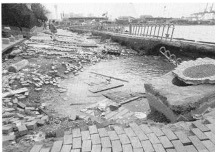
図 1 液状化の被害写真（気象庁技術報告 第 119 号 第 4 章 資料集）
