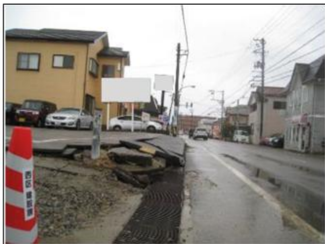
図4 液状化の被害写真（災害時地震・津波報告 令和6年能登半島地震）
