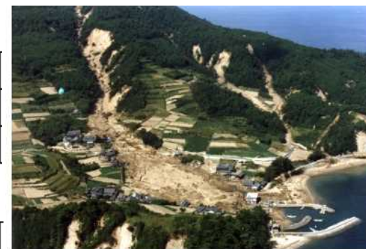
小豆島町(旧池田町)谷尻地区の 土砂災害 (香川県ホームページより)
