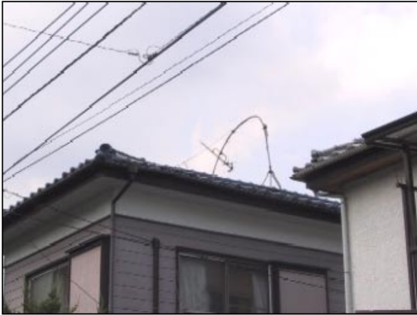
写真1（町田市 野津田地区） 屋根のテレビアンテナが、西側へ折れ曲がり破損。
