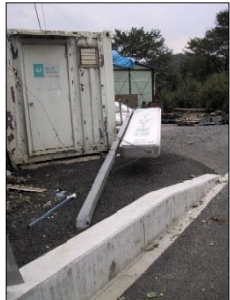
写真4（町田市 小野路交差点付近） 看板が根本から、西側に折れ曲がる。
