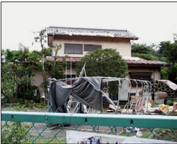
写真3（町田市 小野路交差点付近） 屋根瓦が飛び、家屋の北側に落ちる。
