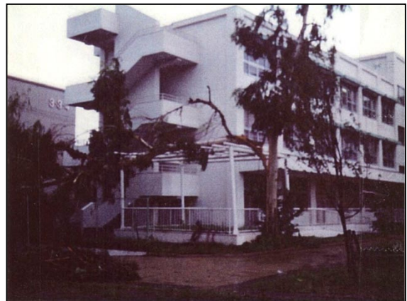
写真12（多摩市 落合地区） 木が幹の途中より折れている。 （写真提供：多摩市役所）
