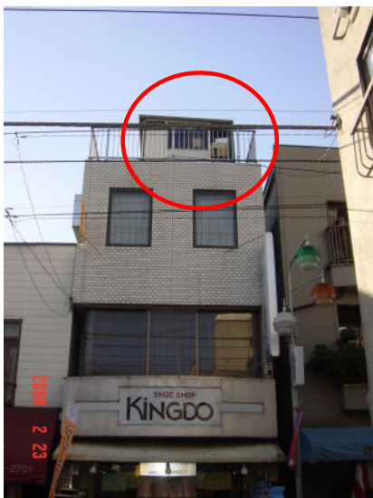
C ドアの破損
