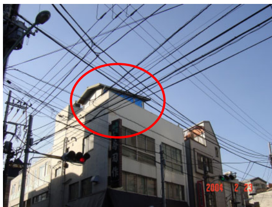
D 壁 (パネル) の飛散
