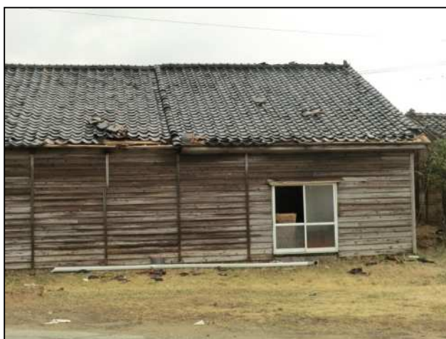
屋根瓦がめくれ落下した納屋 【北東方向撮影】
