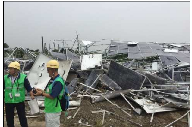
倒壊した太陽光発電施設 （北から撮影）
