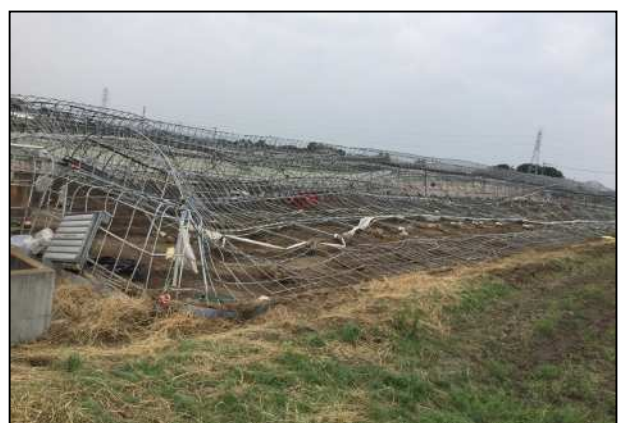
倒壊したビニールハウス （北北西から撮影）
