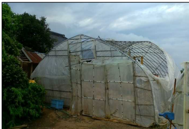
④ 変形したパイプハウス (南東方向から撮影)
