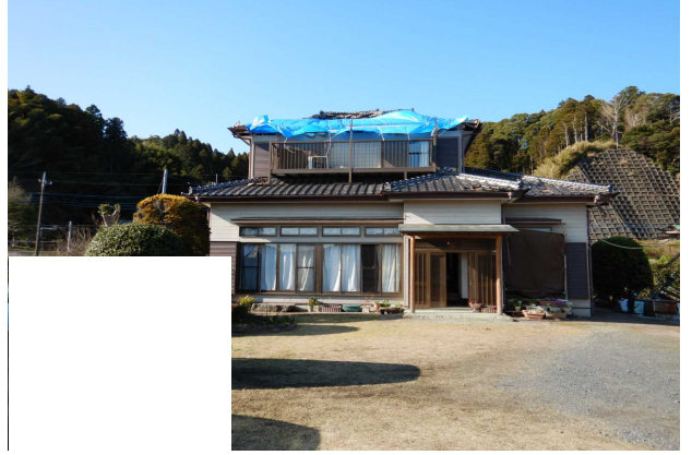
② 屋根が飛散した住家 (南方向から撮影)
