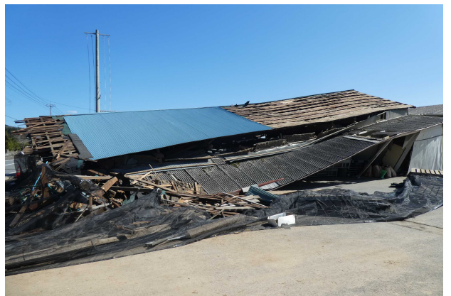
⑥ 倒壊した倉庫 (西方向から撮影)
