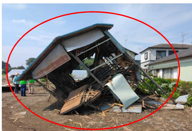
⑥ 倒壊した倉庫 (南方向から撮影)
