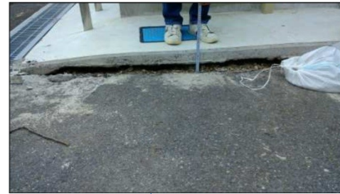
湯梨浜町龍島: アスファルト面の陥没
