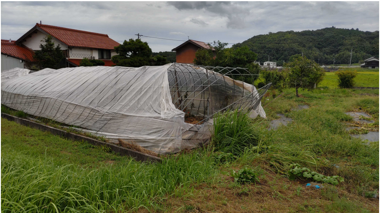
写真② 鋼管の変形したパイプハウス
