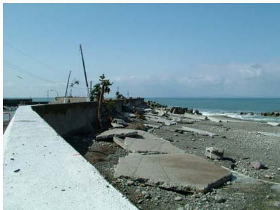
②入善港東防波堤 護岸施設の損傷および電線に引っかかった木の枝
