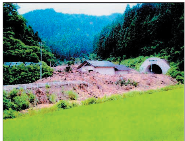
写真 2.1.4.6 三島町中永 (新潟県土木部砂防課提供)
