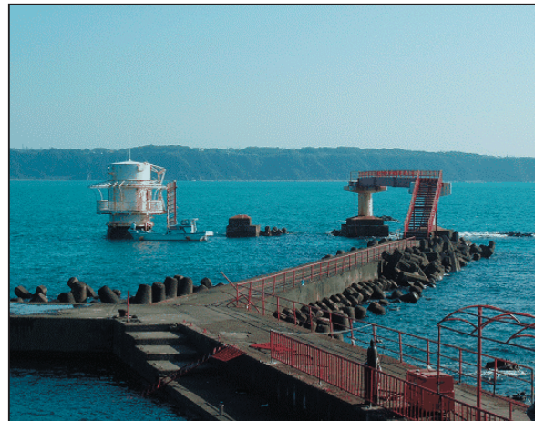
写真 2.6.3.12 西牟婁郡串本町の海中公園センターの海中展 望塔 ブリッジと橋脚が無くなっている。
