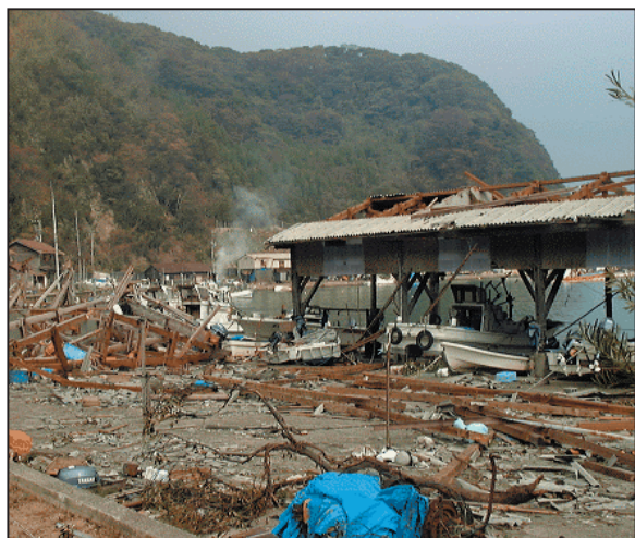
写真2.6.3.2 伊根町蒲入漁港 暴風によりトタン屋根などが破損。
