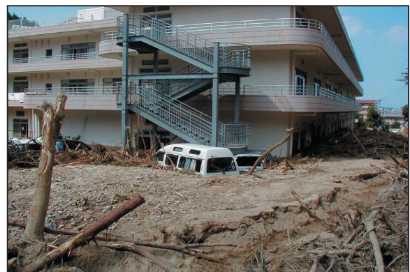
写真2.5.3.4 新居浜市西の土居町御茶屋谷川（土石流） （愛媛県土木部提供）
