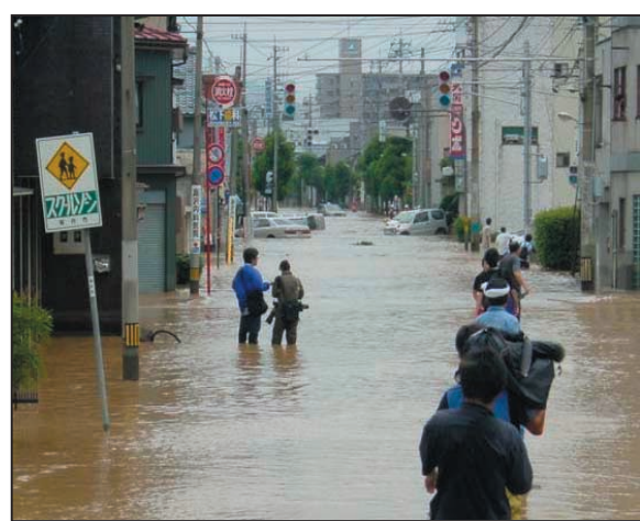
写真2.2.3.2 足羽川破堤後の福井市春日地区
