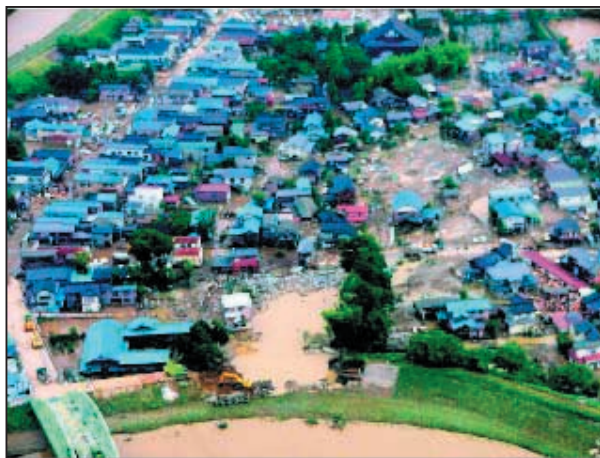
写真 2.1.4.4 刈谷田川破堤状況 (北陸地方整備局提供)
