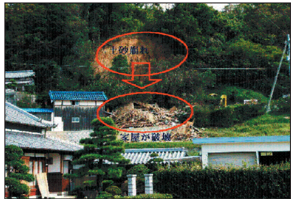
写真 2.6.3.10 津名町里の土砂崩れ現場 家屋が土砂にのみ込まれている。
