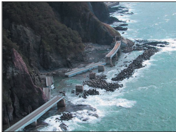
写真2.4.2.7 国道229号 大森大橋落橋被害状況 ( (株)シン技術コンサル提供 )
