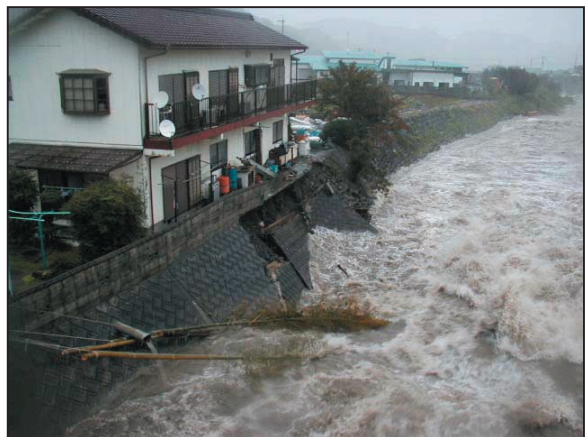
写真 2.5.3.7 四国中央市土居町上野 関川（愛媛県土木部提供）
