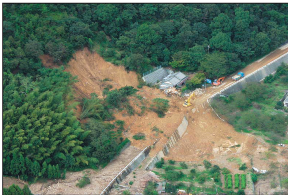
写真2.5.3.2 西条市大久保（愛媛県土木部提供）
