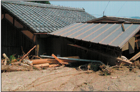
写真 2.6.3.8 滝場地区土砂崩れ現場
