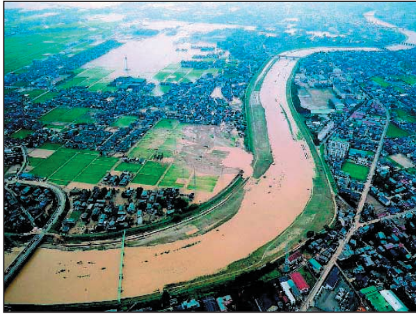
写真 2.1.4.2 五十嵐川破堤状況（北陸地方整備局提供）
