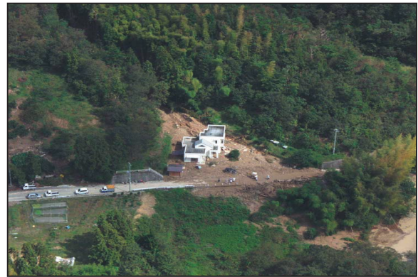
写真2.5.3.3 四国中央市金田町池之奥川 （愛媛県土木部提供）
