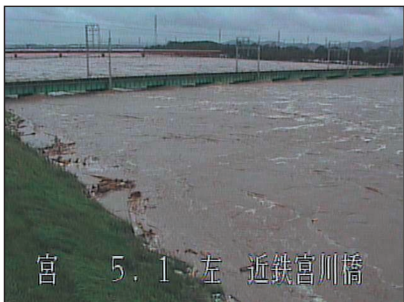
写真 2.5.3.9 宮川の水位上昇により近鉄宮川橋に迫る水面 (三重河川国道事務所提供)
