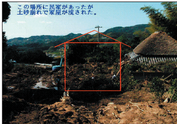
写真 2.6.3.9 津名町生穂の土砂崩れ現場 家屋が流失している。
