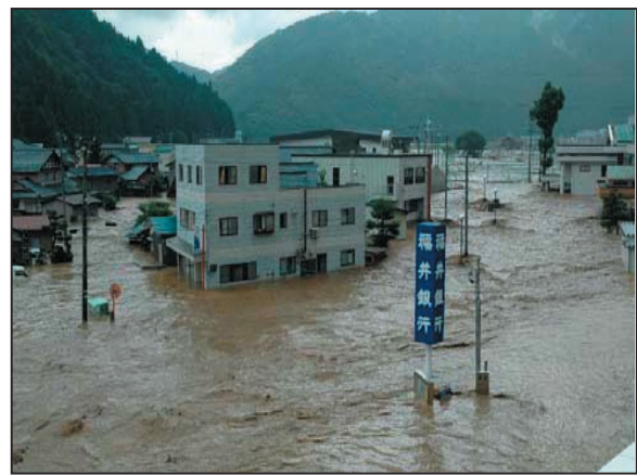
写真2.2.3.5 美山町役場付近の浸水状況（美山町提供）
