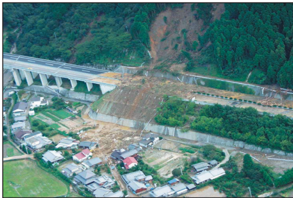
写真2.5.3.1 新居浜市大生院（死者4名） （愛媛県土木部提供）
