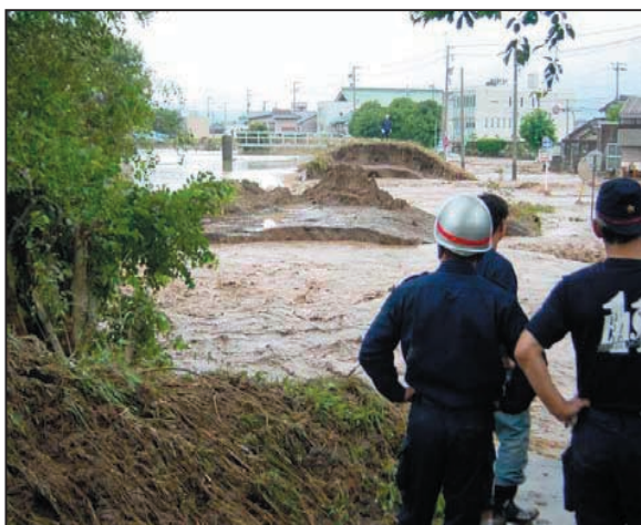
写真2.2.3.1 福井市の木田橋上流足羽川 左岸破堤箇所(破堤幅約54m)
