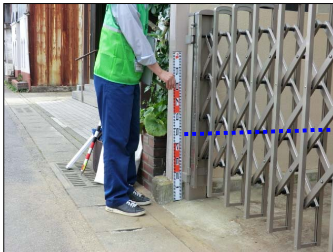
②浸水痕跡 約 0.5m (地上高) [市役所周辺]
