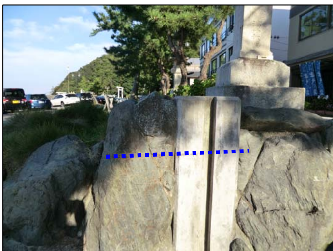
⑤浸水痕跡
