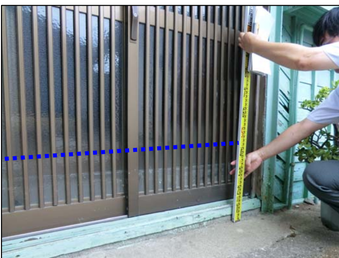
⑥浸水痕跡 約 0.3m (地上高) [坂手町]
