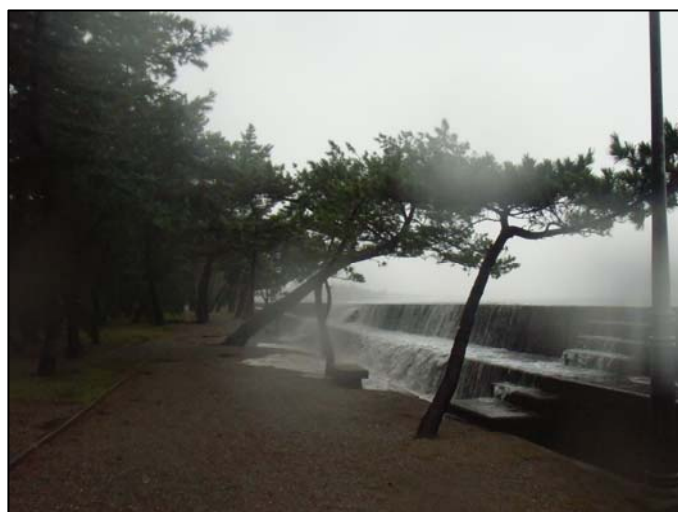
⑥堤防から越水 【伊勢建設事務所提供】
