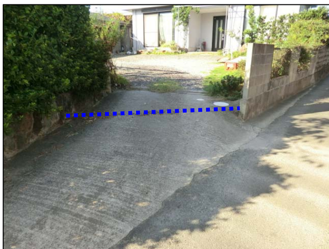
⑥浸水痕跡 [磯部町坂崎]
