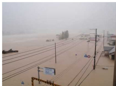
提供：国土交通省近畿地方整備局 熊野川氾濫(新宮市)
