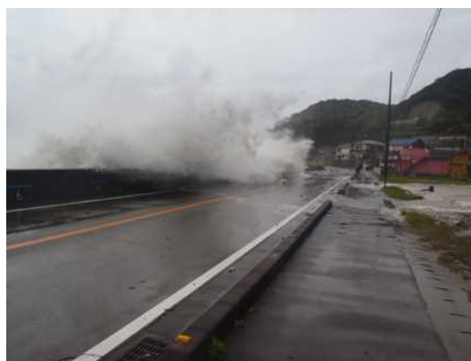
提供：国土交通省近畿地方整備局 和歌山県すさみ町 越波
