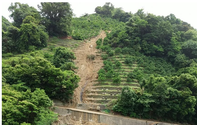
崩落した樹園地（有田市）
