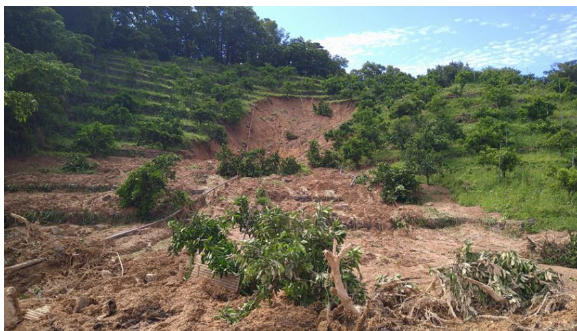
崩落した樹園地（有田川町）
