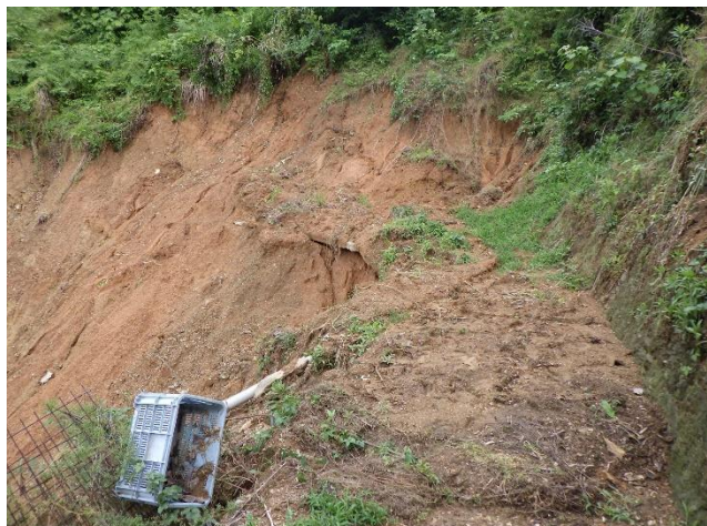
被災した農道（九度山町）
