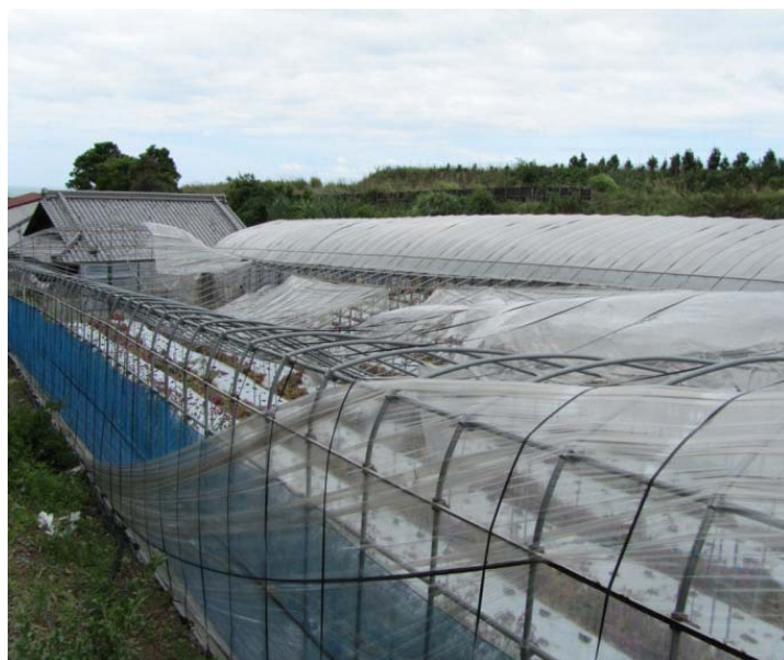
第2図 壊れたビニールハウス
